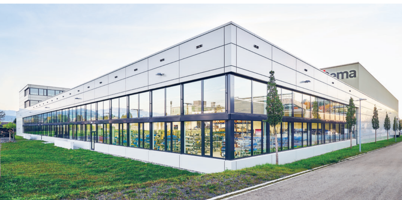
Neben den grosszügigen Verglasungen besteht die Fassade aus rund 6200 m 2 scharfkantigen Verbundplatten in Form einer hinterlüfteten Vorhangfassade.
