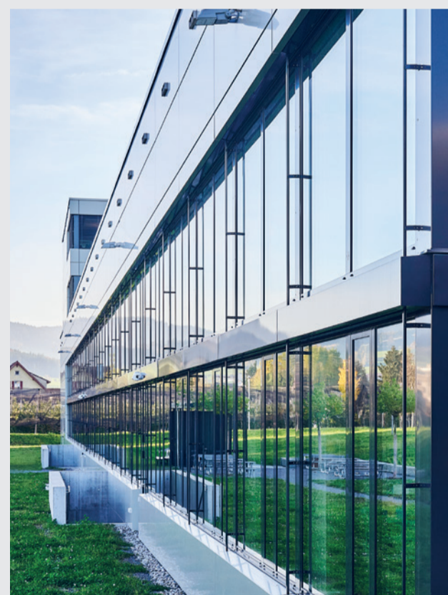
Die Profile der zweistöckige Elementfassade wurden als Sonderpressung mit einer Profilaufdupplung hergestellt.
