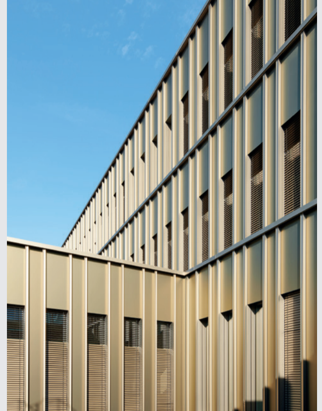
Die Fassadenelemente sind bis zu drei Stockwerke hoch.
