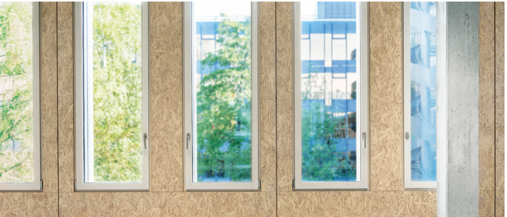
Die innovative Hybridfassade wurde aus isolierten Holzpaneelen vorgefertigt.
