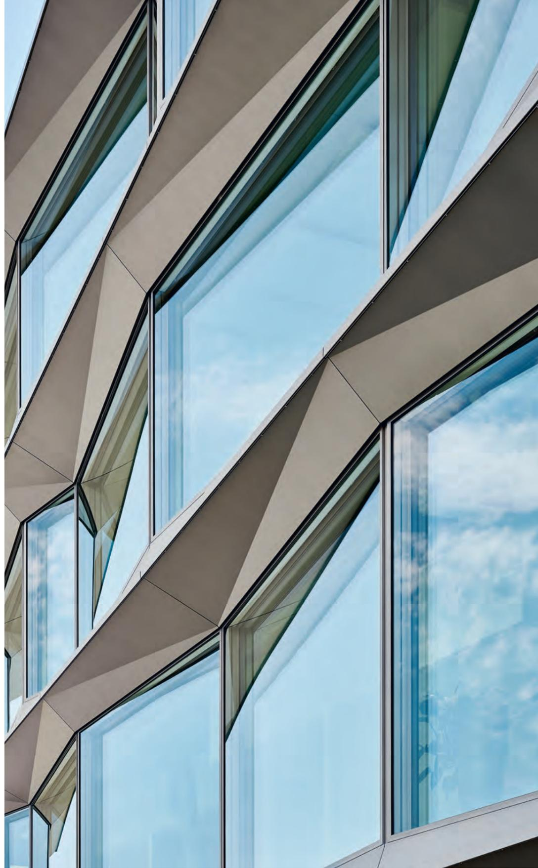
*Die komplexe Geometrie der Gebäudehülle des neuen Bürogebäudes mit 154 AEPLI-AIR-CONTROL® -Elementen bringt die Leistungskompetenz von Aepli hervorragend zum Ausdruck. Die integrierte Beschattung wird mit der Sonneneinstrahlung automatisch gesteuert.*
