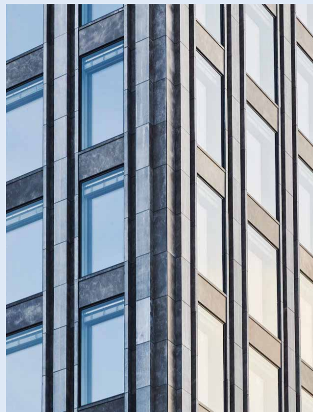
Bereits am Boden auf die Elemente montiert: hochwertige Filiberti-Natursteine aus dem malerischen Apennin-Gebirge.
