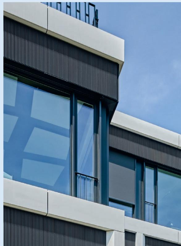
In die massgeschneiderte Unterkonstruktion wurden alle Gestaltungselemente der Fassade eingehängt.
