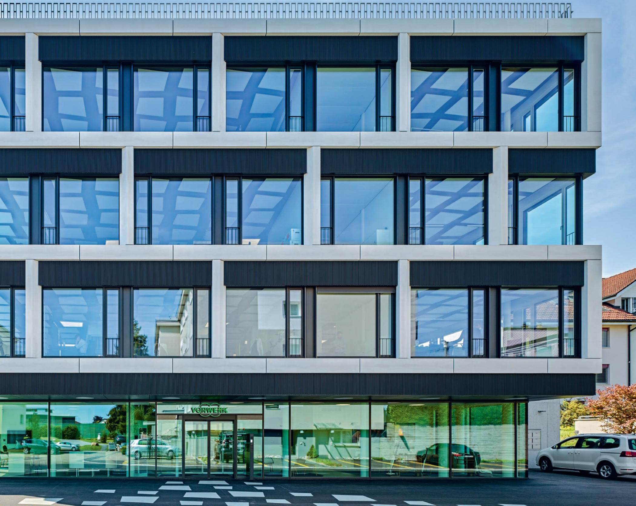
*Nordfassade EG: Haupteingang integriert in klassische Pfostenriegelfassade. OG: Fensterelemente mit Sturzverkleidung aus wellenförmigem Trapezprofil, Glasfaserbetonelemente in weissem Kontrast zu den dunklen Fenstern.*
