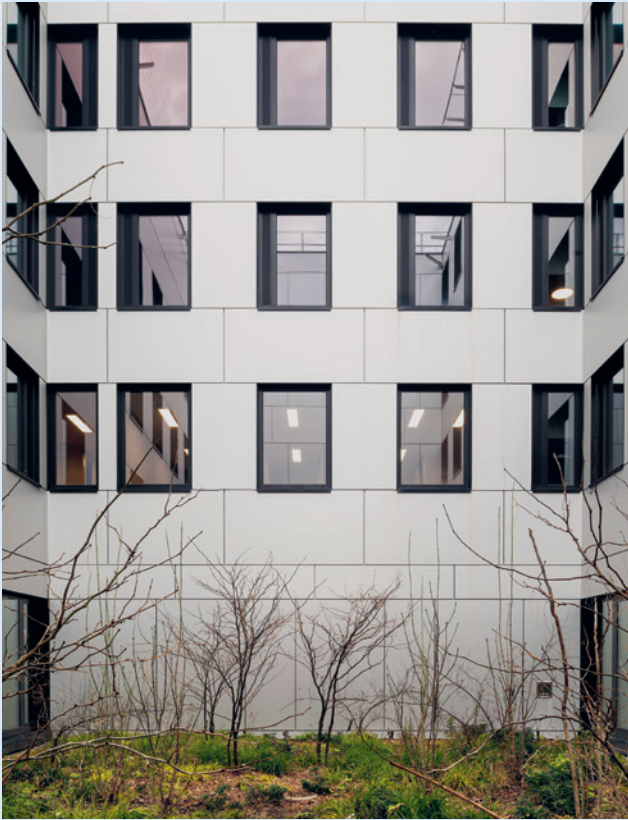
Hinterlüftete Metallfassade im Innenhof
